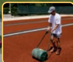
Finitura e rullatura dei giunti/Finish and rolling joints/Finition et rmeture des joints/ Fertigbearbeitung und Wälzen der Schnittstellen
