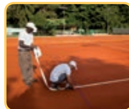
Posizionamento delle righe di gioco/Placement play lines/Placement des lignes de jeu/Positionierung der Spiel-Linien
